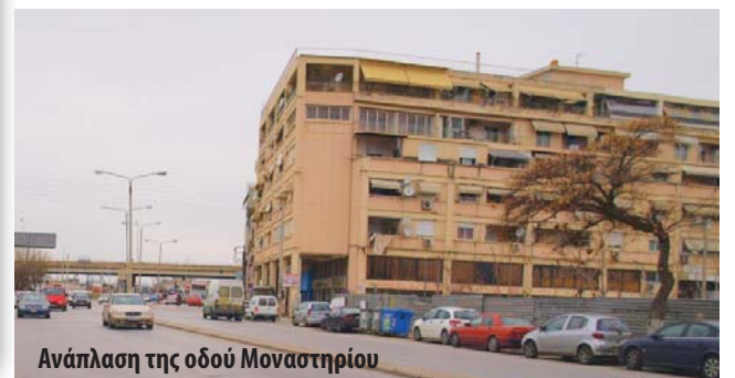
Κατασκευή της υπόγειας οδού Μοναστηρίου - Έλλης Αλεξίου - Αγ. Παρασκευής και αντιστρόφως
